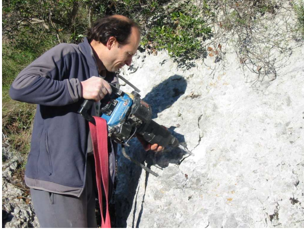
Travaux de sécurisation du chemin de la grotte de la Baume St-Vérédème (SIC n°9) (© SMGG)
