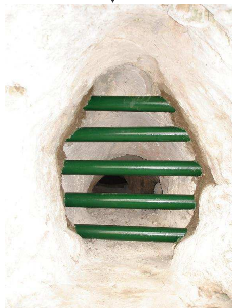
Grilles à barreaux horizontaux installées en décembre 2007 à la grotte de la Sartanette (SIC n°9) (© M. PICART)
