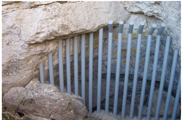
Grille installée en février 2006 à une des deux entrées de la grotte des fées (SIC n°10) (© GCP)
