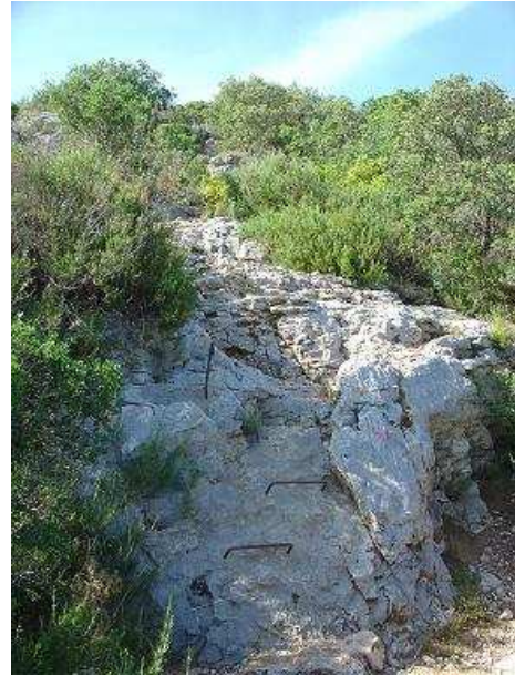
Exemple de marche installées (SIC n°9) (© M. NEMOZ)
