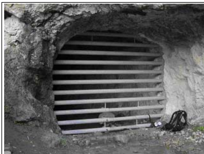
Tunnel 54 (Lac Esparron) à trois barreaux coulissants
