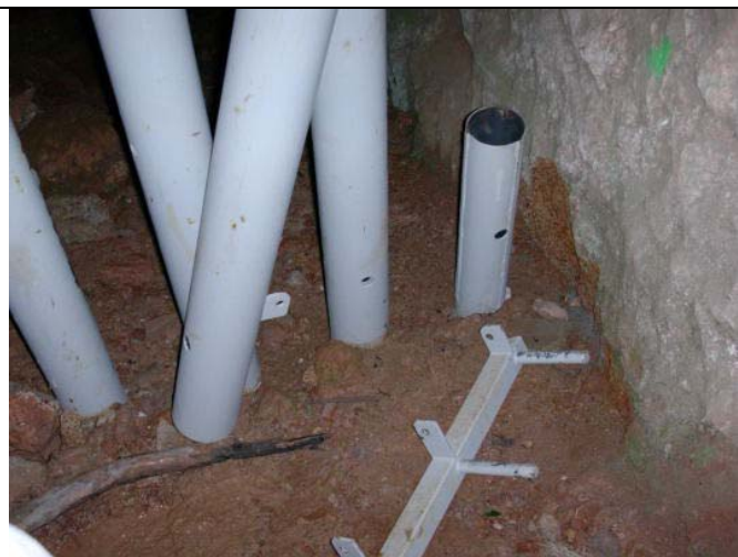
Fermeture ouverte vue de l'extérieure avec un barreau enlevé sur les trois amovibles
