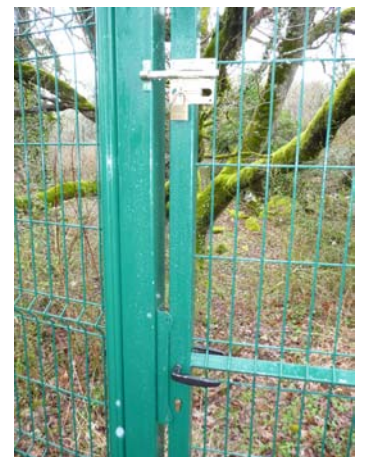
La serrure a été renforcée par 2 targettes avec cadenas
