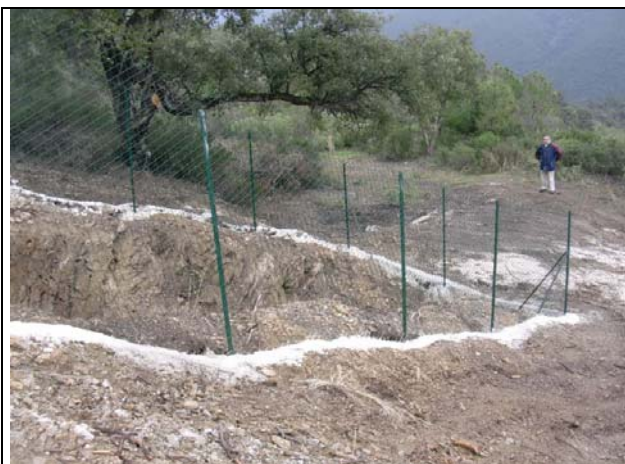
VA4 juste après les travaux
