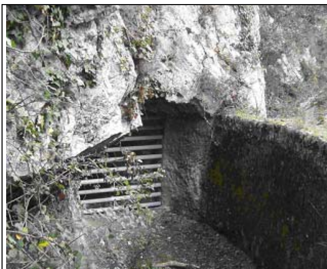
Tunnel 44 côté amont
