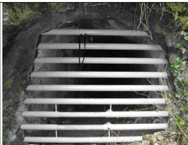
Tunnel 44 côté aval à deux barreaux coulissants
