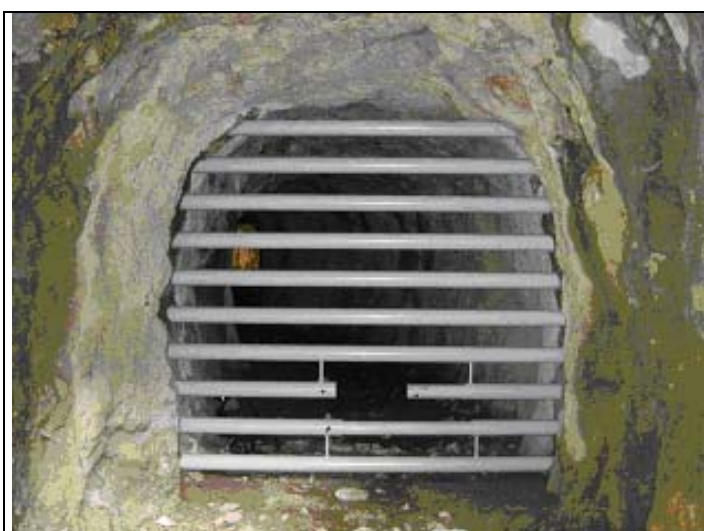
Tunnel 22 (Quinson) avec un des deux barreaux ouverts
