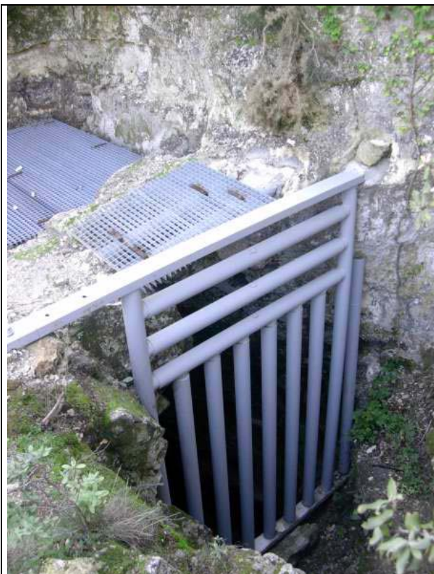
Vue extérieure de la grille verticale et du caillebotis de l'entrée inférieure
