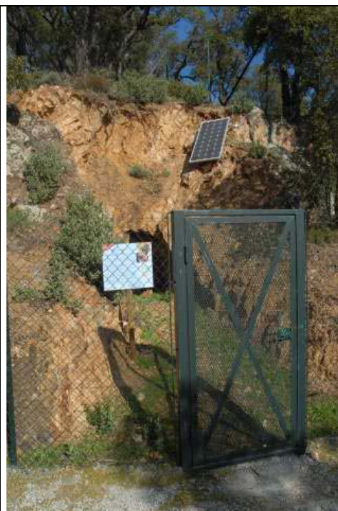
VA0 avec panneau et alimentation du Batapi (automate compteur de chauves-souris)
