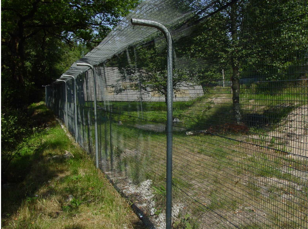
Figure 9 : Clôture anti-loutres mise en place dans la pisciculture du Moulin de Barthou à Bugeat en Corrèze (© Frédéric LEBLANC).
