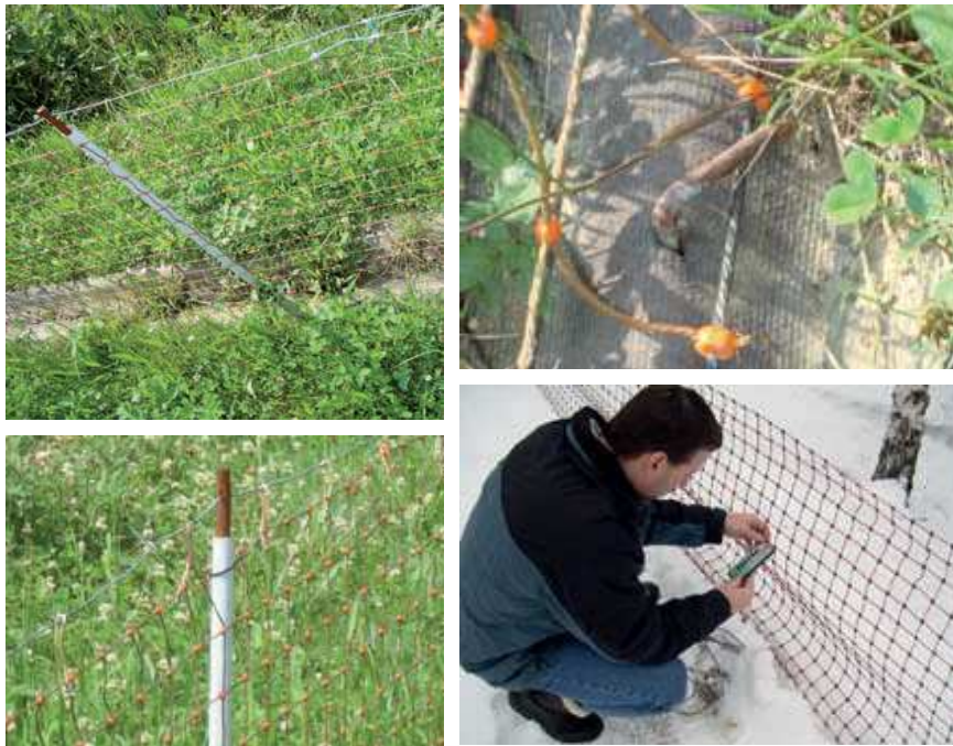
Figure 13 : Grillage électrifié tendu par un fil de fer et fixé au sol par des crochets (COLLECTIF 2010).
