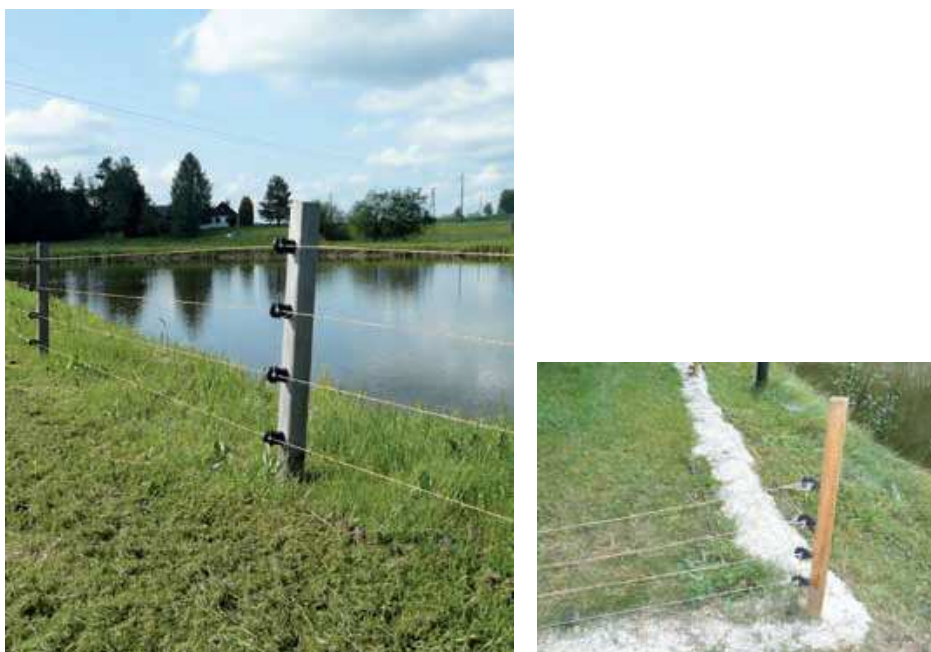
Figure 14 : Série de 4 fils électrifiés espacés de 10 cm. La végétation est tondue ou recouverte (COLLECTIF 2010).
