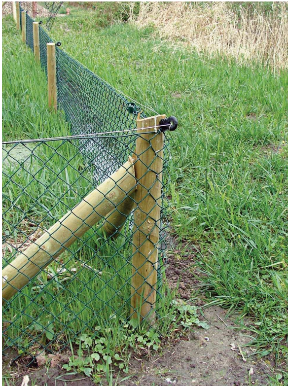
Figure 10 : Grillage de 70 cm de haut enterré sur 30 cm et doublé d'un fil électrique sur le dessus (KRÜGER 2008).
