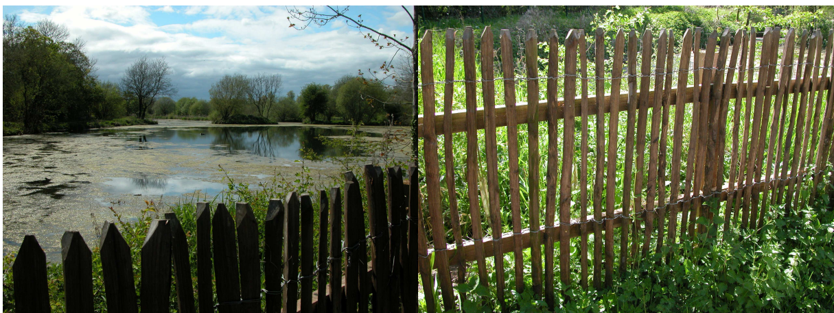
Figure 25 : Palissade en noisetier servant à protéger un étang de pêche (© Chris MATCHAM).
