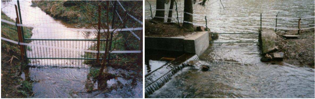
Figure 18 : Grilles destinées à empêcher la Loutre de pénétrer dans l'étang par les voies d'eau (© Czech Otter Foundation, www.vydry.org).
